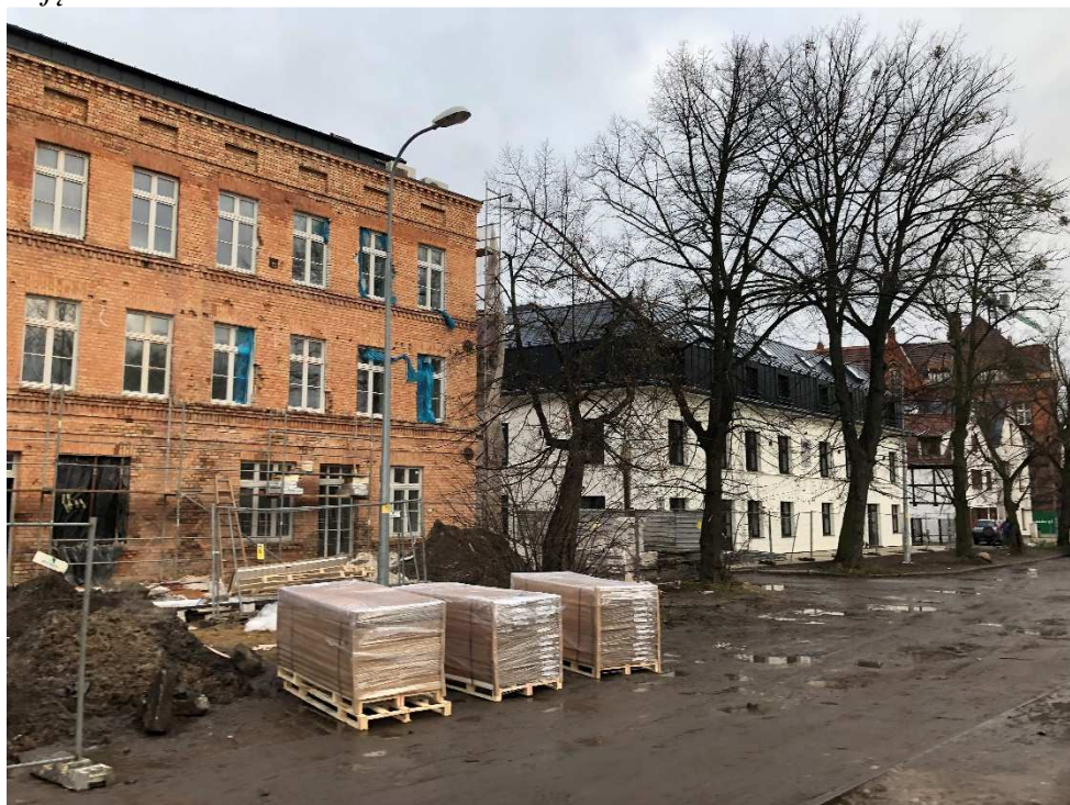
Budynek zamyka pierzeję zabudowy na odcinku ul. Kieturakisa – Kurza stan na dzień 14.01.2020 r.
